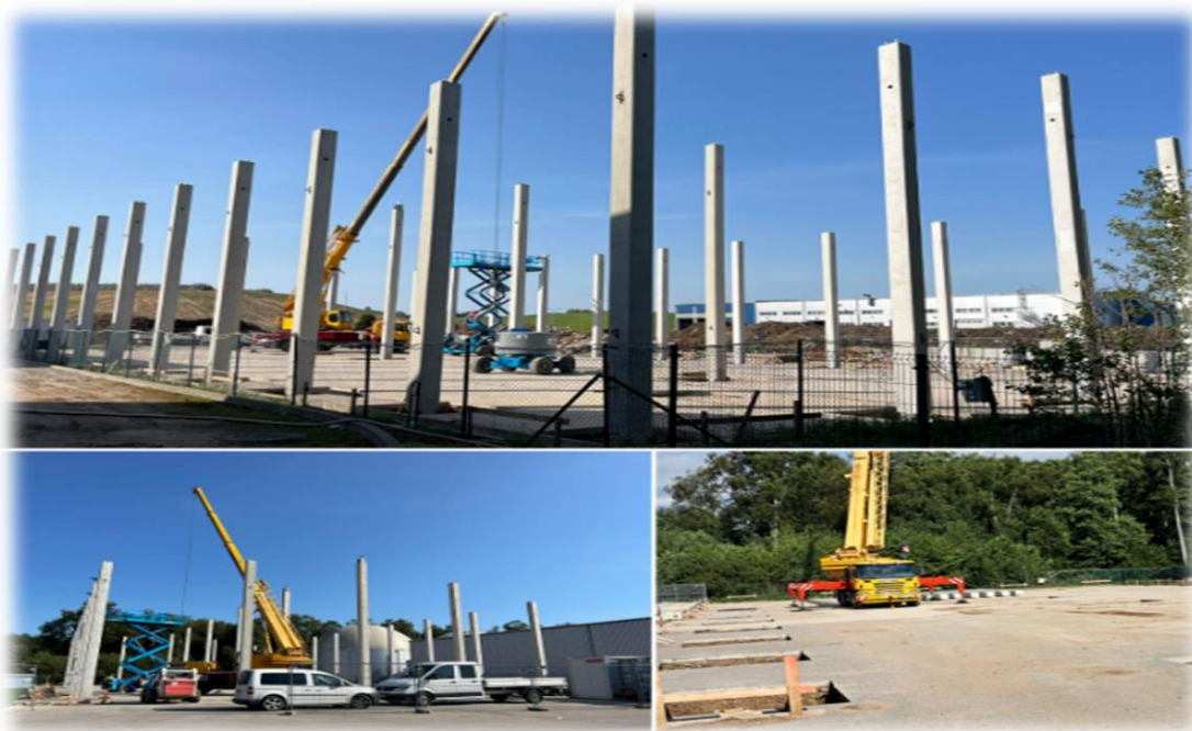
3 pav. Komposto apdorojimo stoginės įrengimo darbai
